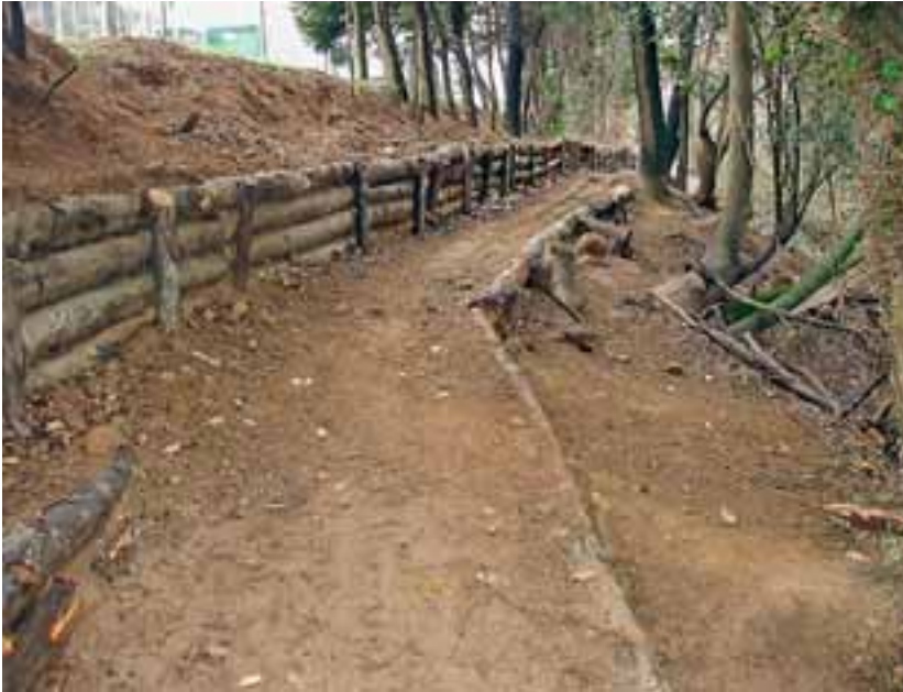
Entre d'altres actuacions, s'ha realitzat la delimitació del camí i s'han condicionat els talussos / Regidoria de Medi Ambient
